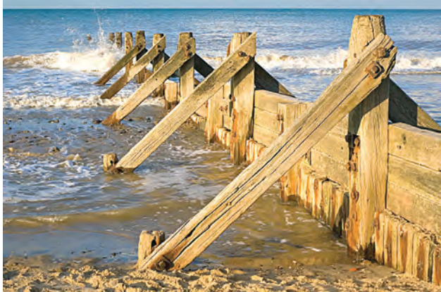
نصب حفاظ عمودی
