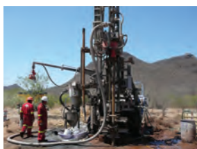
ب) دستگاه حفاری گمانه
