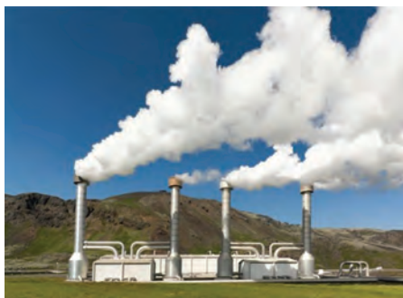
شکل ۱۱-۶- نیروگاه زمین گرمایی مشکین شهر- اردبیل
