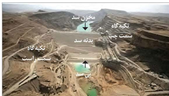
شکل ۴-۵- نمایی از بخش‌های مختلف یک سد
