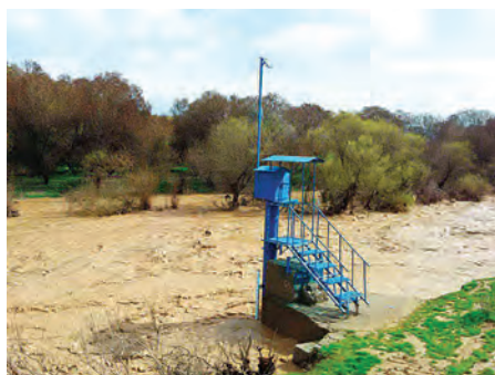
شکل ۲-۳. ایستگاه اندازه‌گیری آبدهی رود
