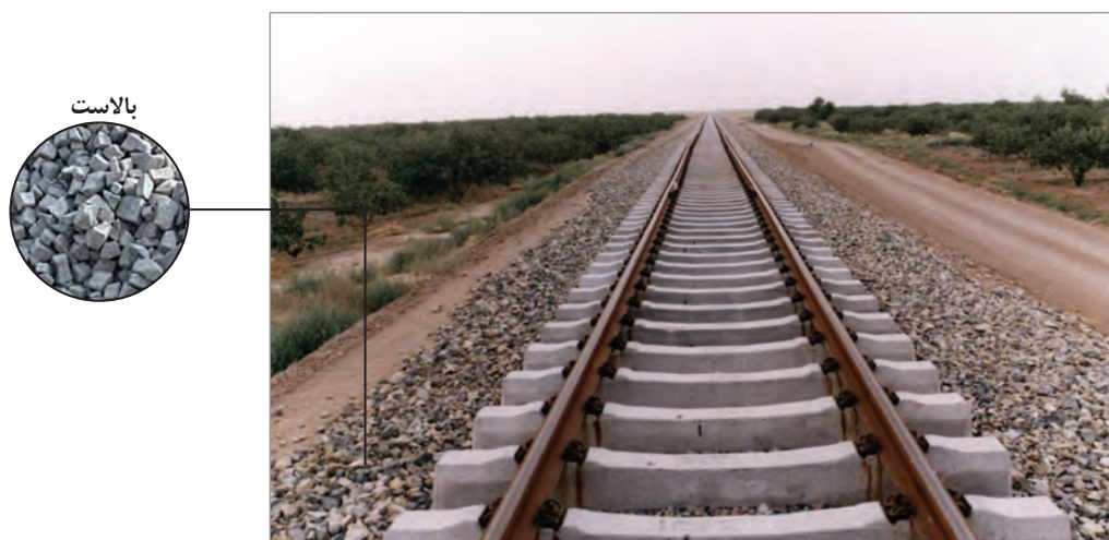
شکل ۴-۱۱- بالاست در زیرسازی جاده ریلی
