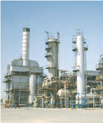
ب) نمای بیرونی برج تقطیر در پالایشگاه
