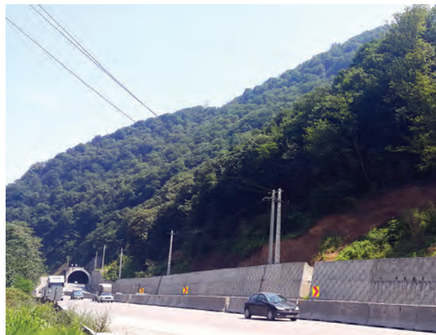
نصب حفاظ بتونی - جاده قائم‌شهر
