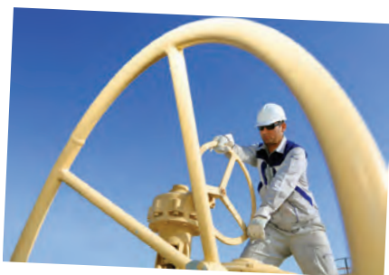
یکی از کارکنان خط لوله در حال باز و بسته کردن ولو (شیرنفتی)
